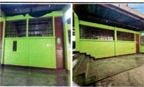
Foto 12: Pintura en muro exterior
