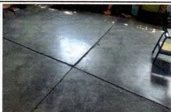
Foto 9: Sustrucción de piso cerámico aula 3
