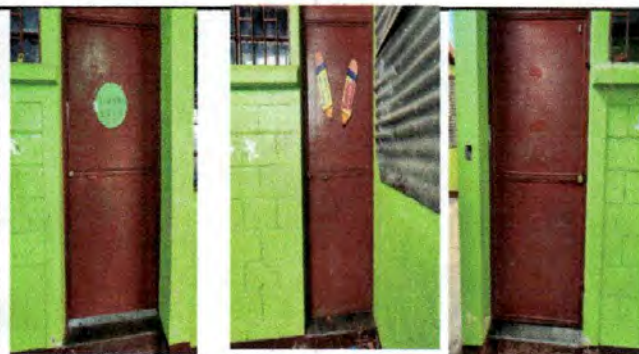
Foto 4: Sustitución de puerta lado izquierdo aula 2, puerta del centro aula 3, puerta lado izquierdo aula 4
