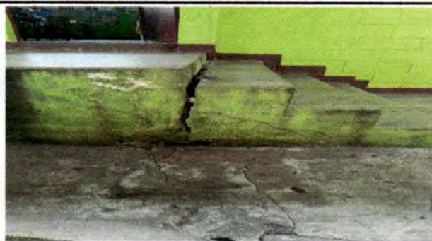
Foto 6: Reparación de piso de torta de concreto
