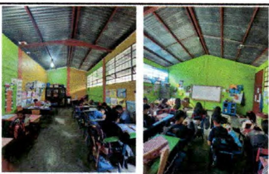
Foto 11: Pintura en muros interiores
