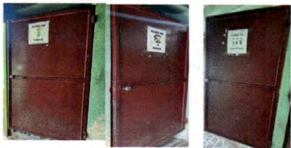
Foto1: Mantenimiento a estructura en 3 puertas de baño (lijado, cepillado aplicación de pintura)
