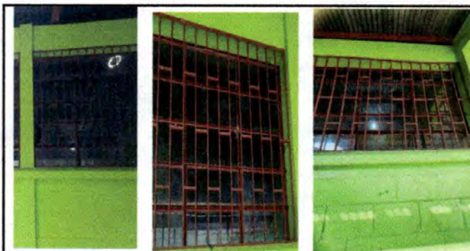
Foto 5: Sustitución de 4 vidrios de dos aulas
