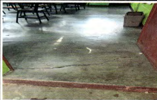
Foto 7: Sustrucción de piso cerámico aula 1
