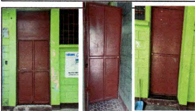
Foto 3: Sustitución de puertas lado izquierdo cocina, puerta del centro de adentro de cocina, puerta lado derecho aula 1
